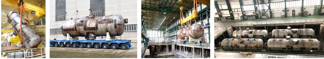
図 16 蒸気発生器の原子炉建屋からタービン建屋の仮置き場への移送
