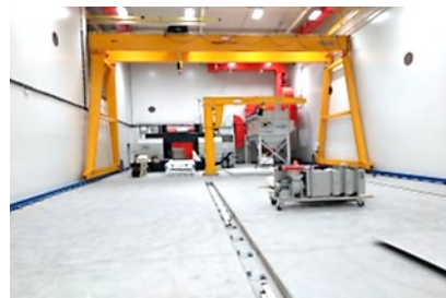
図5 蒸気発生器の乾式切断場所
